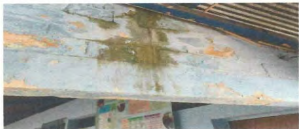
Foto 3: REPARACION DE REPELLO Y CERNIDO DE PAREDES
