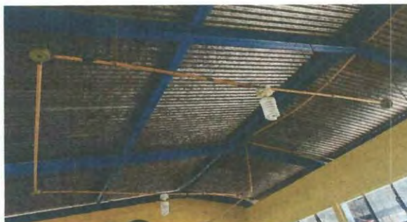
Foto 4: REPARACION DEL SISTEMA ELECTRICO
