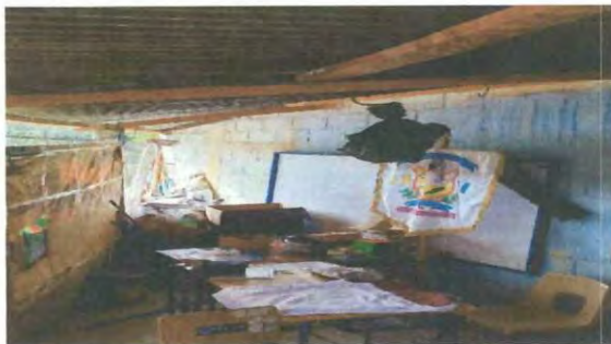
Foto 2: ESTRUCTURA DE TECHO
