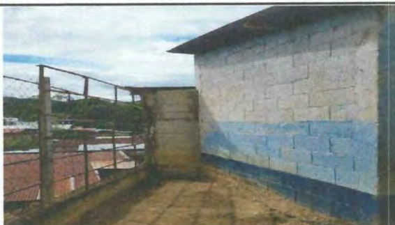
Foto 6: PINTURA EN MUROS INTERIOR Y EXTERIOR
